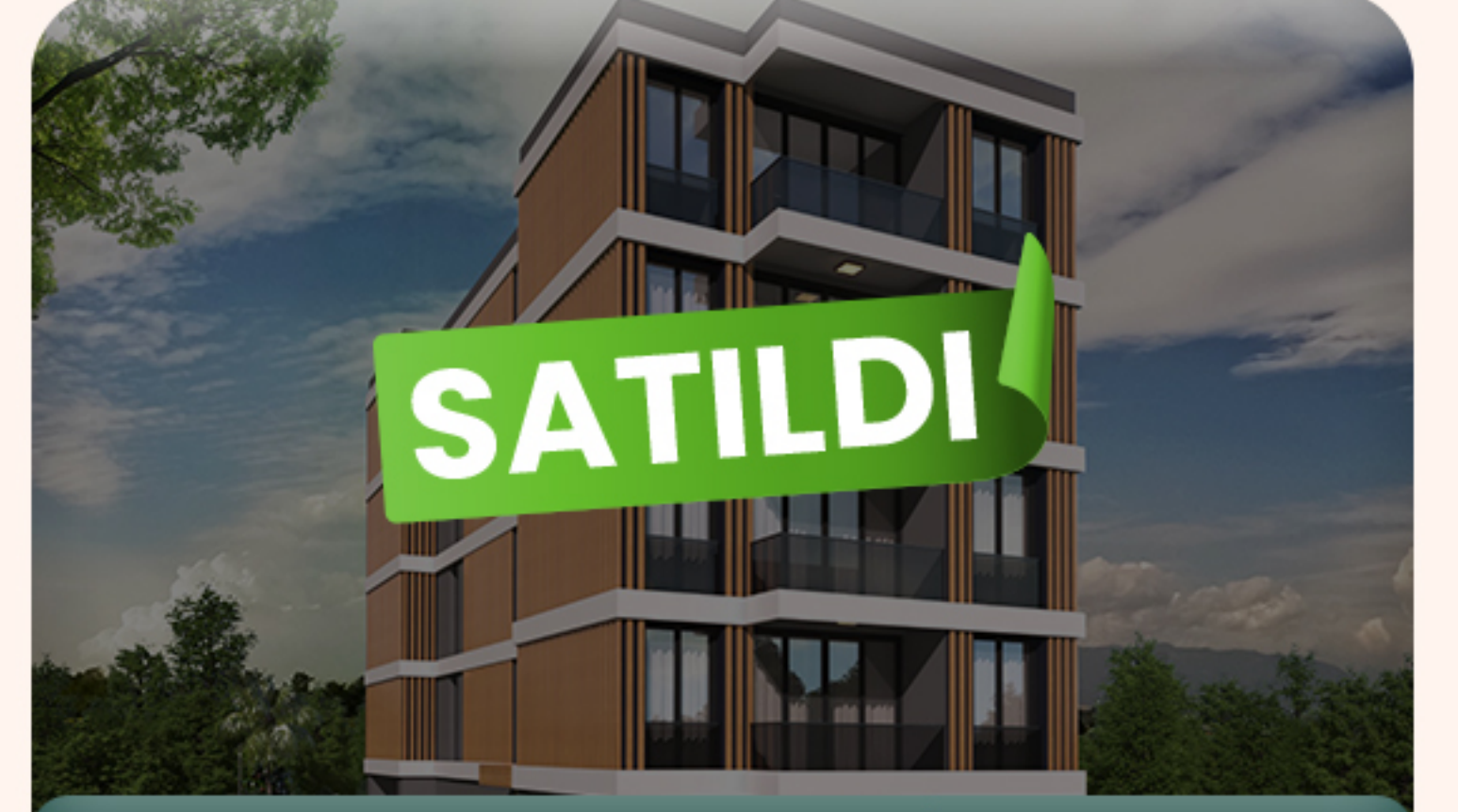
• Novo Park 3 | Bursa / Yolçatı
